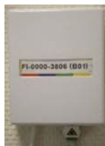
Figure 8 : FTTE passif NRO - exemple de PTO
